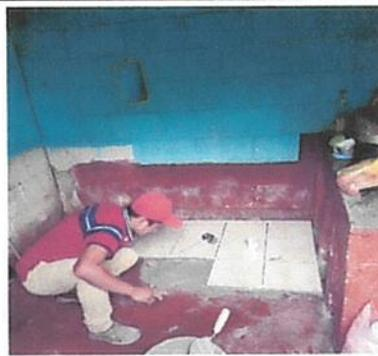
Foto 4: Previa instalación de plancha y chimenea
